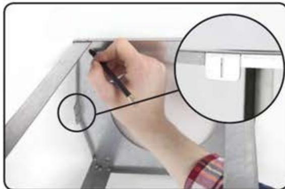
Dabei ist darauf zu achten, dass die auf der Abbildung ersichtlichen Haltehaken für das obere Kaminteil in Richtung der späteren Ausrichtung der Haube zur kurzen Haubenseite zeigen und die Halterung über dem Kochfeld vermittelt ist. Haben Sie die Bohrlöcher für die Halteschrauben eingebohrt, können Sie nun die Deckenhalterung an der Decke verschrauben.
