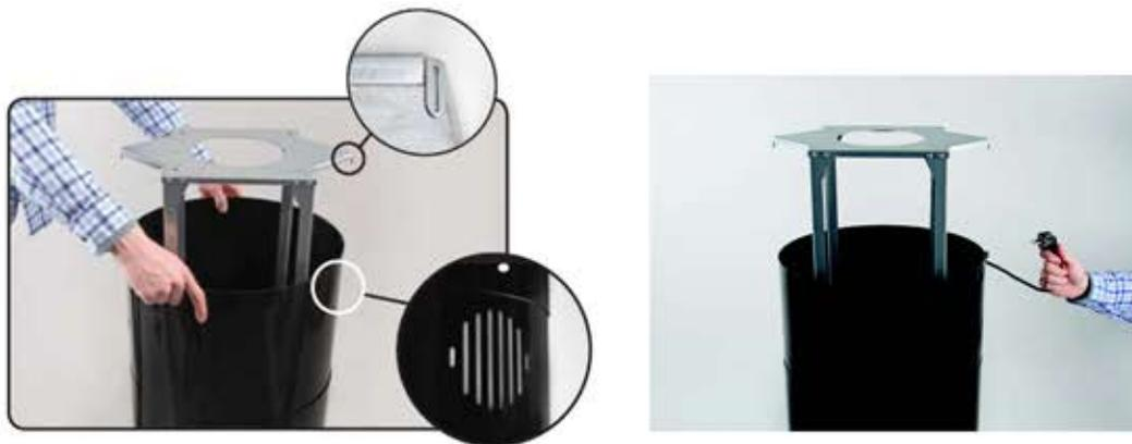
Nun wird die Haube mit allen Anbauteilen gem. den bisher beschriebenen Schritte an die ganz zu Anfang gebohrten Deckenlöcher verschraubt.
