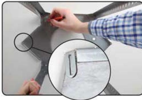
Dabei ist darauf zu achten, dass die auf der Abbildung ersichtlichen Haltehaken für das obere Kaminteil in Richtung der späteren Ausrichtung der Haube zur Seite zeigen und die Halterung über dem Kochfeld vermittelt ist. Die markierten Bohrlöcher können nun gebohrt werden.
